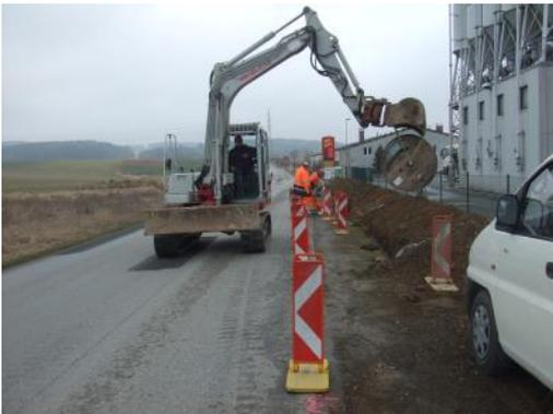
Im Zuge der Sanierungsarbeiten der Stützmauer entlang der L55 durch die Strm Raabs/Thaya erfolgten auch die Grabarbeiten für die Verlängerung der Straßenbeleuchtung durch den Bauhof der Stadtgemeinde Groß-Siegharts. Es wird auch eine 70km/h-Beschränkung aufgestellt werden.
