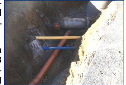
Da es bei Starkregenereignissen immer wieder zu Überflutungen von Kellern im Straßenzug „Am Huppelteich“ kommt, ist es notwendig 3 Haushalte mit neuen Kanalanschlüssen zu versorgen. Der Einbau eines kurzen Leitungssystems, welches parallel zum bestehenden Kanal verlegt wird, ist die einzige Möglichkeit die Haushalte trotz breites eingebauten technischen Mittel vor der Überflutung der Keller zu schützen.
