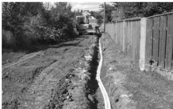
Im Zuge dieser Straßenbauarbeiten wurde unter Mithilfe des Bauhofs die Erdverkabelung für die Beleuchtung des Weges zwischen Mittergasse und Grabenfeldstraße, dem sogenannten „Schwarzen Steig“ hergestellt.
