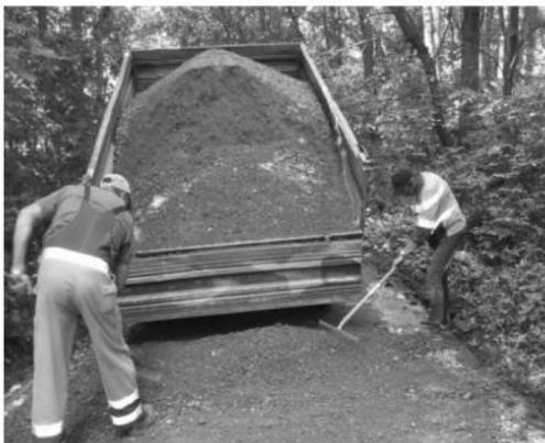
Durch die starken Regenfälle in den letzten Monaten entstanden erhebliche Fahrbahnschäden am „Gollingweg“ in Sieghartsles. Diese machten eine Sanierung unumgänglich. Die Aufbringung des Feinmaterials und die anschließenden Verdichtungsarbeiten wurden von den Mitarbeitern des Bauhofs durchgeführt.
